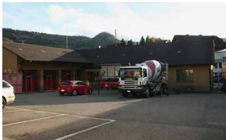
Wohnhaus (o.) und Werkhof (u.) Oth. Stebler AG (OSAG), Foto Toni Hänggi, 2013
