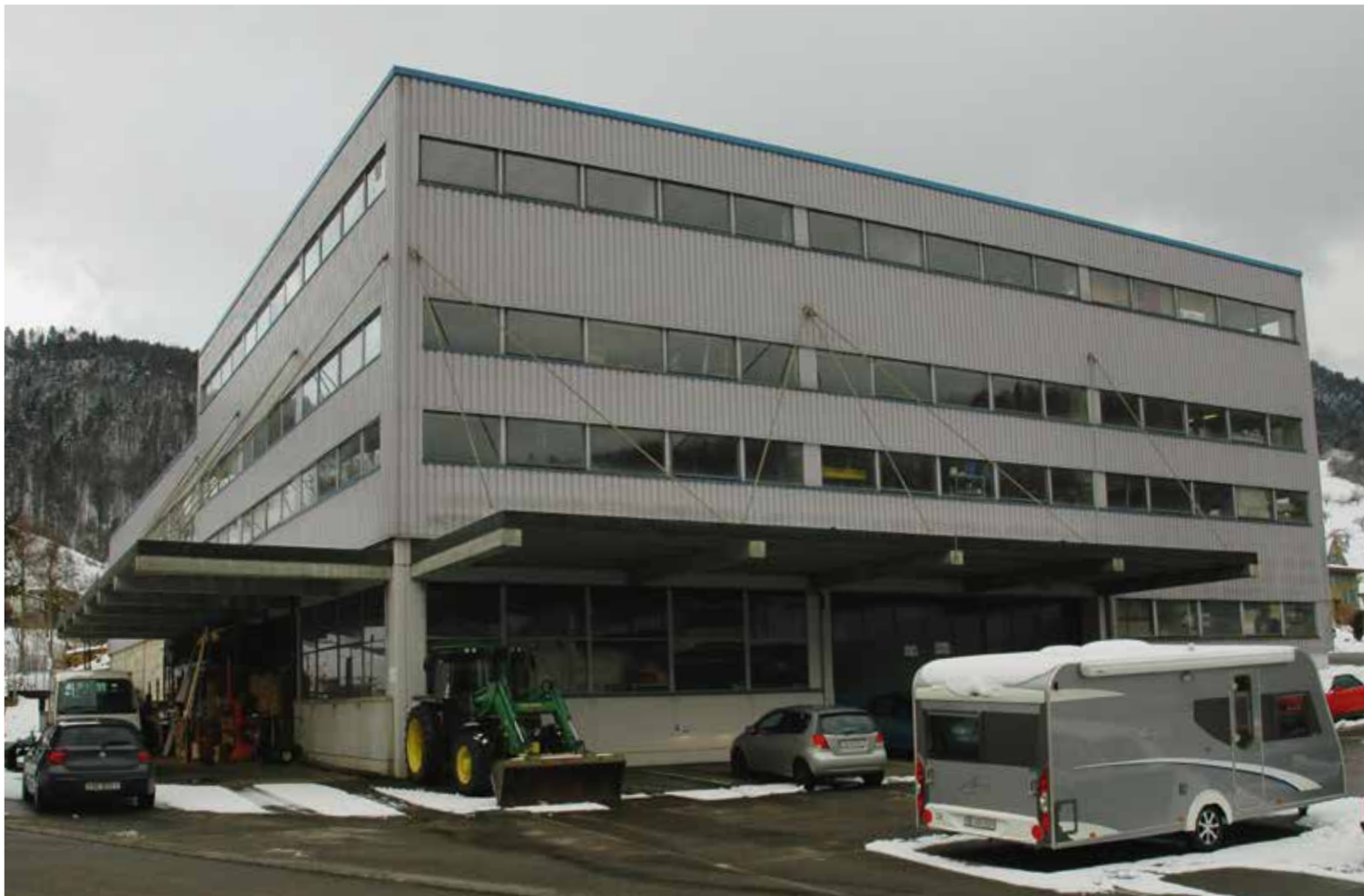
Die renovierte Abfüllhalle der ehemaligen Meltinger Mineralquellen AG Foto Willi Menth, 2015
