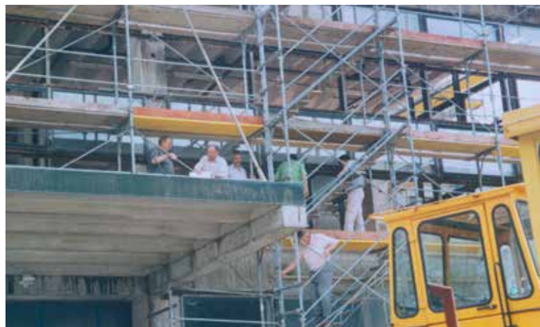
Am Anfang standen umfassende Renovationsarbeiten Baufoto vom 20.7.2001
