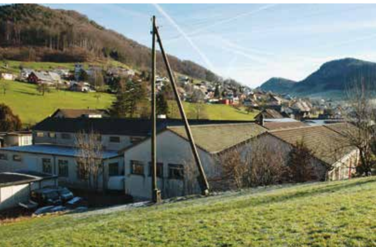
Fasslager und Spritzerei der ehemaligen Stesa AG Foto Willi Menth, 2015
