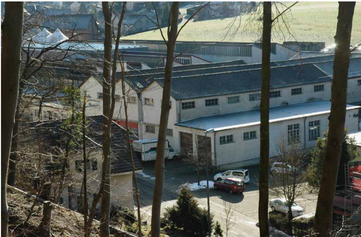
Blick auf die renovierten Gebäude an der Grellingerstrasse Foto Willi Menth, 2015
